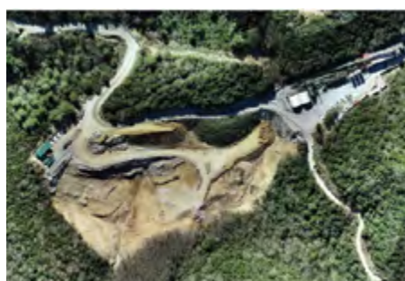
Εργασίες αποκατάστασης και κατασκευή του νέου εργοστασίου λιθογόμωσης της Ολυμπιάδας (Φεβρουάριος 2021)
