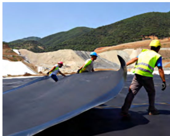
Ένα τμήμα της αδιαπέρατης 4 στρώσεων στεγάνωσης στον Κοκκινόλακκα
