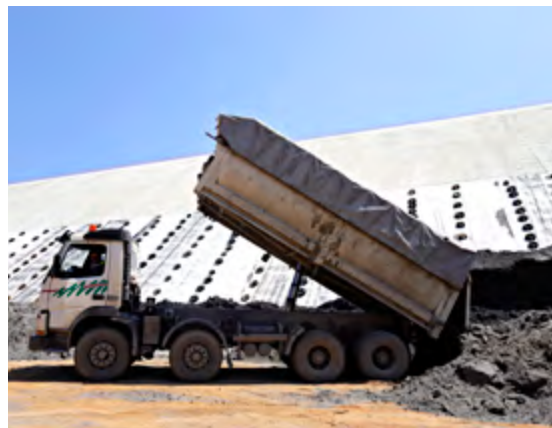
Απόθεση αφυγρασμένων τελμάτων στον ΧΞΑ Κοκκινόλακκα
